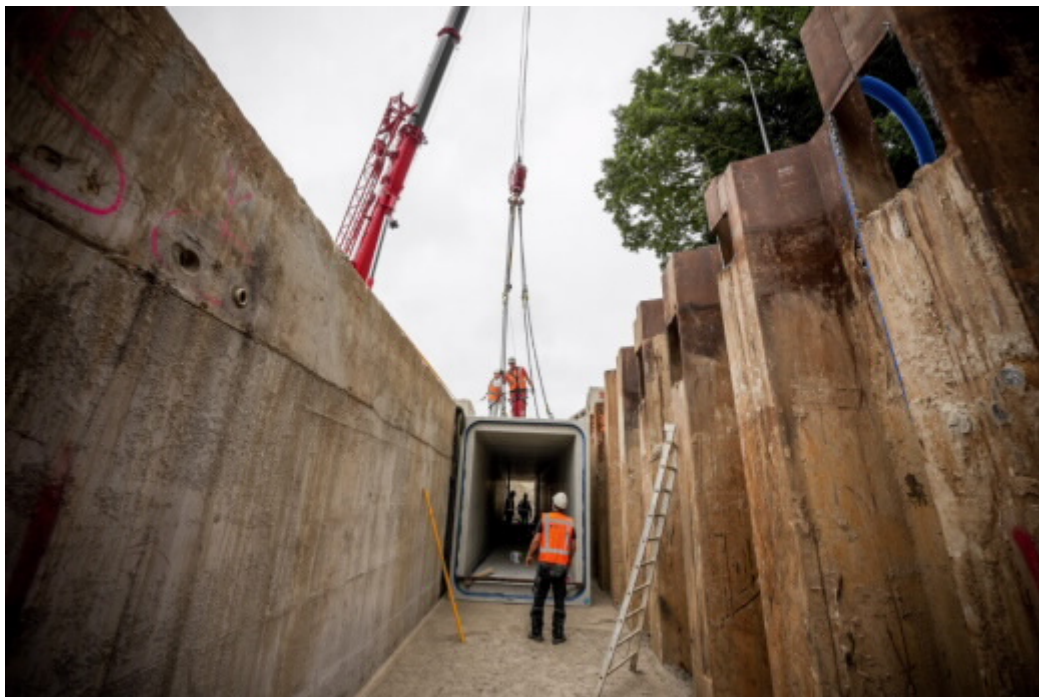
Kabelgotenkanaal:
