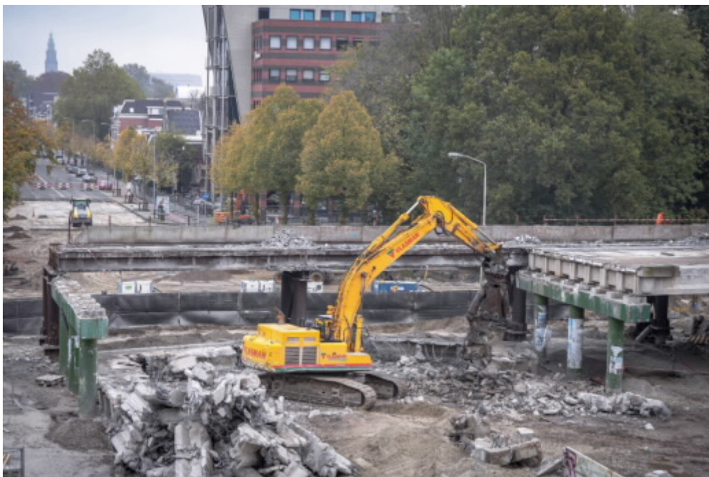
Afbeelding: werkzaamheden Hereweg (fotograaf: Raymond Bos)
