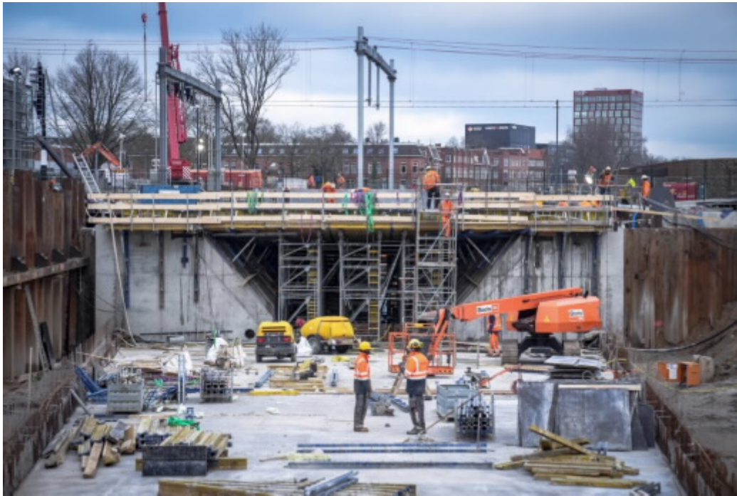
Afbeelding: werkzaamheden Esperantotunnel (fotograaf: Raymond Bos)
